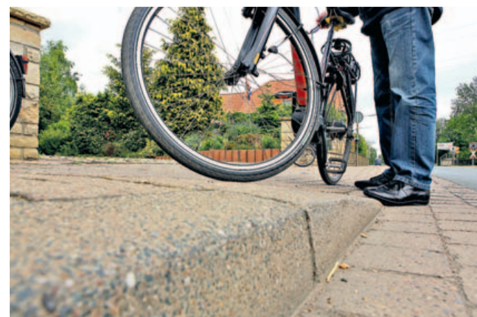
Abgesenkte Hochbordanlagen bedeuten Berg- und Talfahrt für den Fahrradfahrer. Die zugehörigen Zufahrten bedeuten sogar Gefahr.
